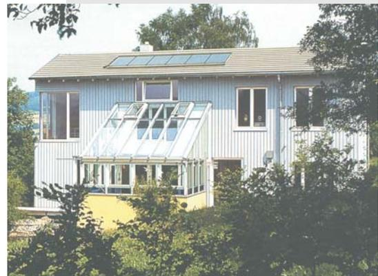
Solarmodule auf einem Satteldach
