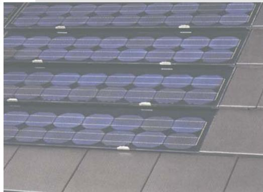
Solarmodule in die Dachfläche integriert
